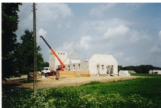
14. Początki budowy kaplicy.
