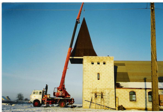
17. Montaż dachu na dzwonnicy.
