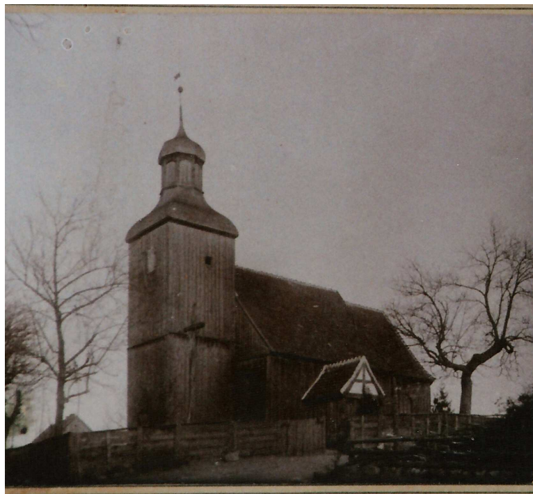
5. Kościół drewniany w Pinczynie wybudowany w 1743 r.
